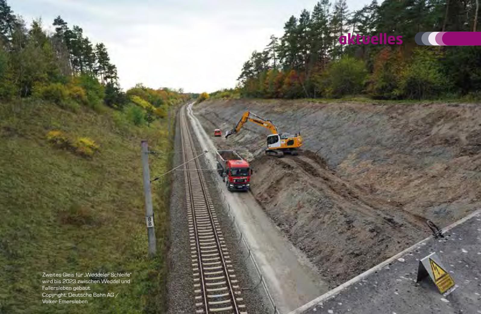
Zweites Gleis für „Weddeler Schleife“ wird bis 2023 zwischen Weddel und Fallersleben gebaut.
